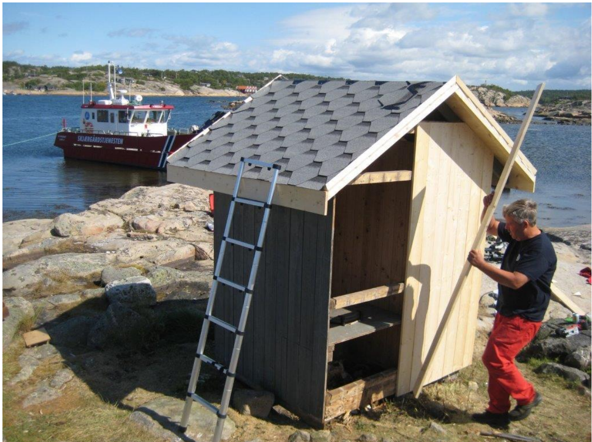
Tom Eilertsen i arbeid med rehabilitering av toalettbod på Sauholmen ved Utgårdskilen 2014
