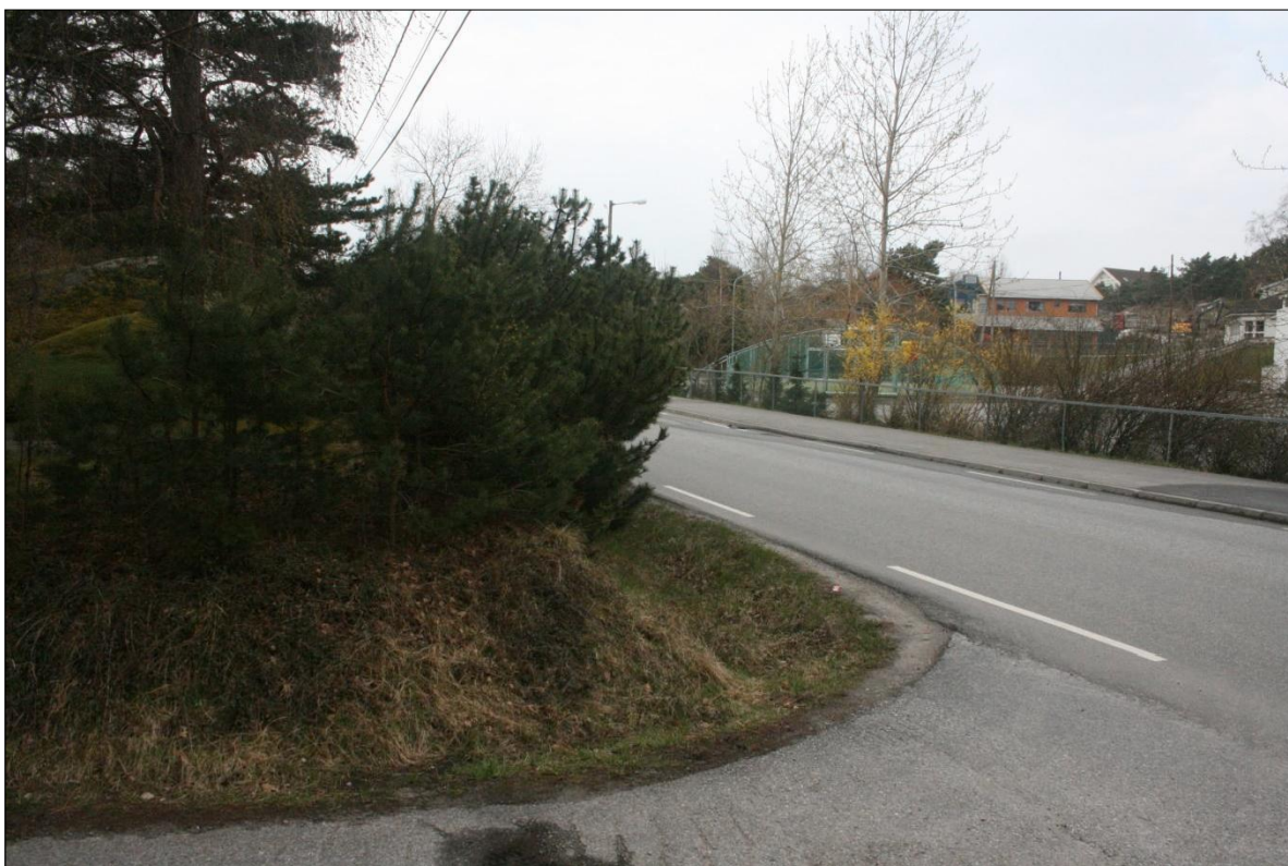
Figur 7. Krysset mellom Åsen og fv472 er til dels uoversiktlig på grunn av utfylling og beplantning.
