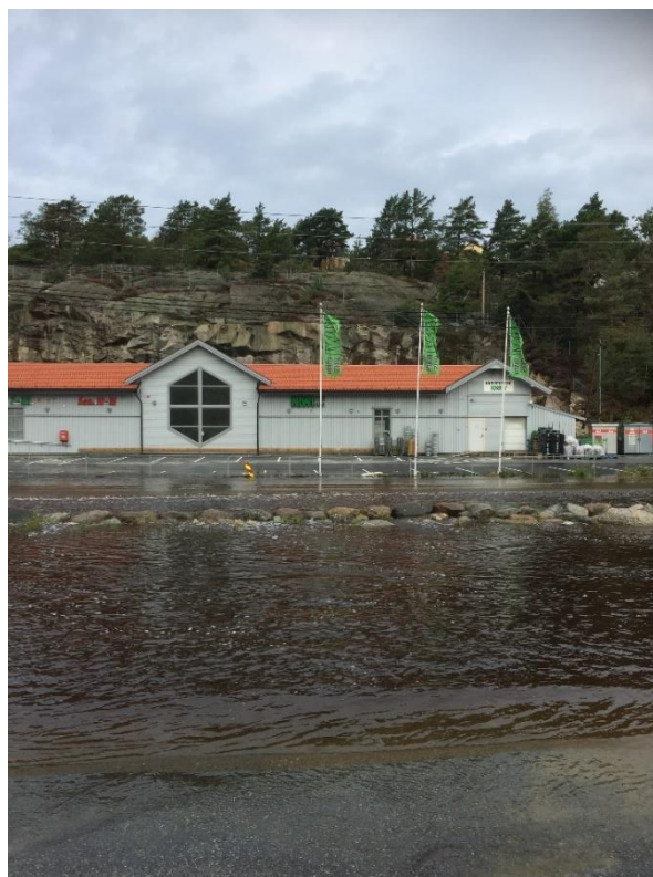
Figur 22: Oversvømmelse som følge av høyvann.
