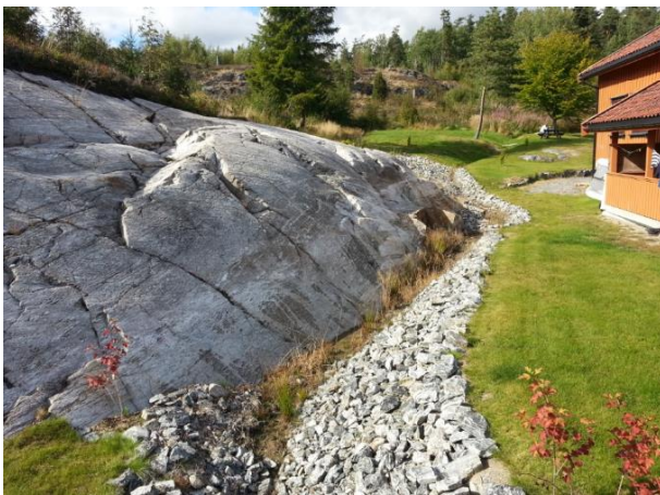
Figur 15: Avskjærende pukkgroft. Gårdsbruk Funderud Antirust. Foto: Multiconsult
