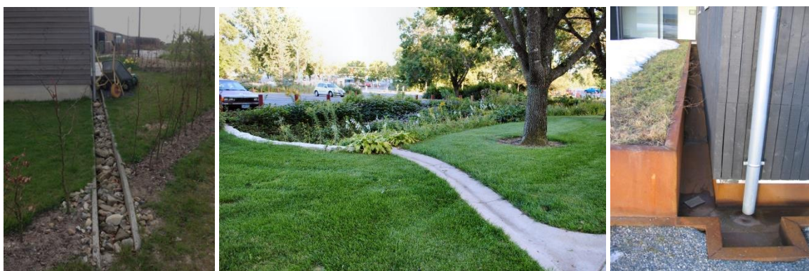
Figur 5: Tv. Bortledning av takvann fra bolighus til plantefelt (Rémy, 2020). Midt: Overvann føres til regnbed (Tennessee, 2013). T.h. Åpne vannrenner for samling av takvann. Kontrollstasjon Svinesund. Foto: Multiconsult
