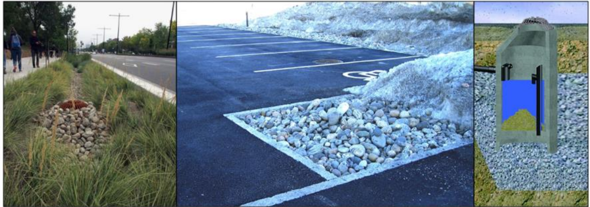
Figur 14: T.v: Infiltrasjonsgrøft (Gobeille, 2018). Midt: Kontrollstasjon Svinesund. Foto: Multiconsult. T.h. Infiltrasjonssandfang (Loe, 2020).
