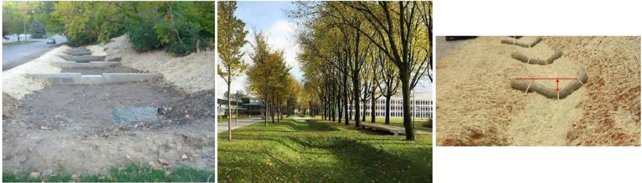
Figur 9: T.v. eksempler av terskel av betong, Midt: jordmasser (Public Space Toolbox, 2016), t.h fiberpølser
