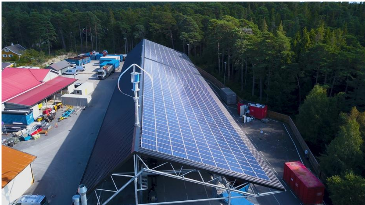
Sandbakken miljøstasjon med solcellepanel og vindmølle
