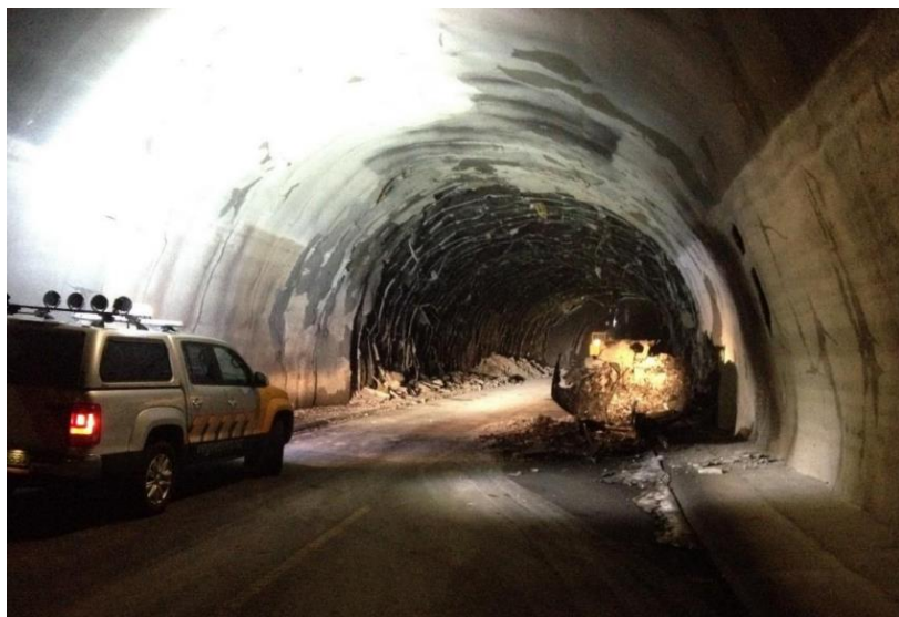
Foto 9 - Utbrent tankbiltilhenger i Skatestrømstunnelen, Foto: Petter Hole, Statens vegvesen
