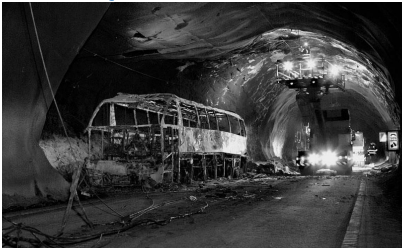
Foto 8 - Bussen var helt oppbrent etter brannen i Gudvangatunnelen i 2015. Foto: Arild P Sjøvik, Statens vegvesen
