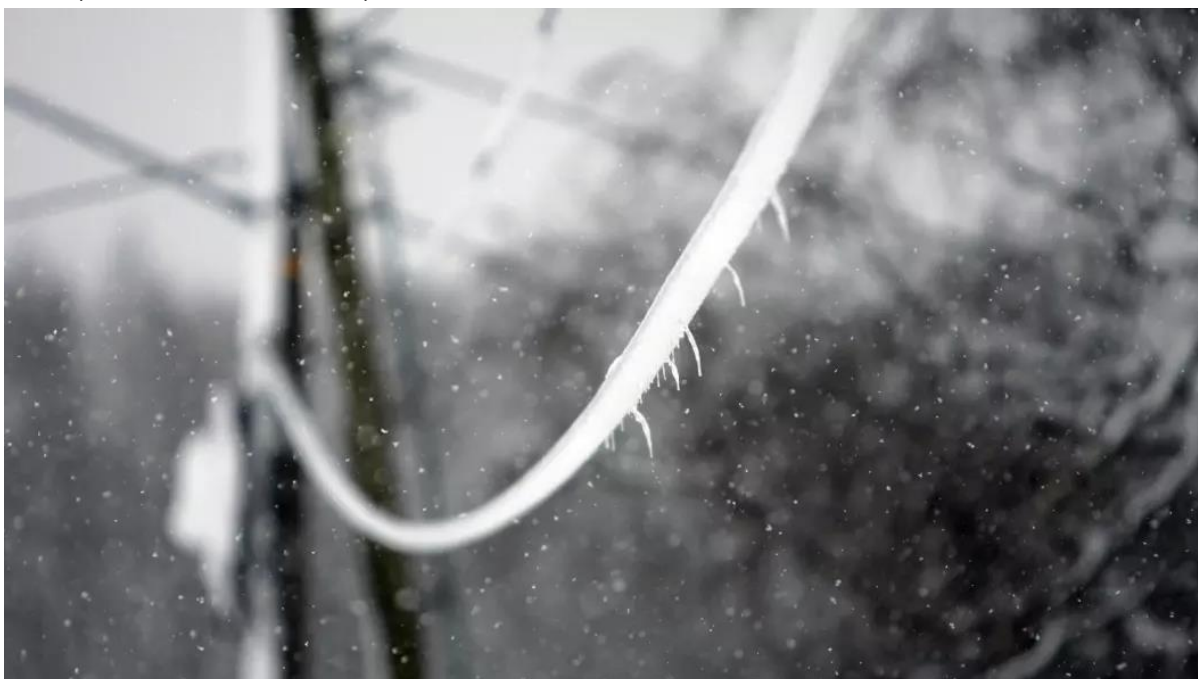
Bilde 1 - Ising på strømledning
